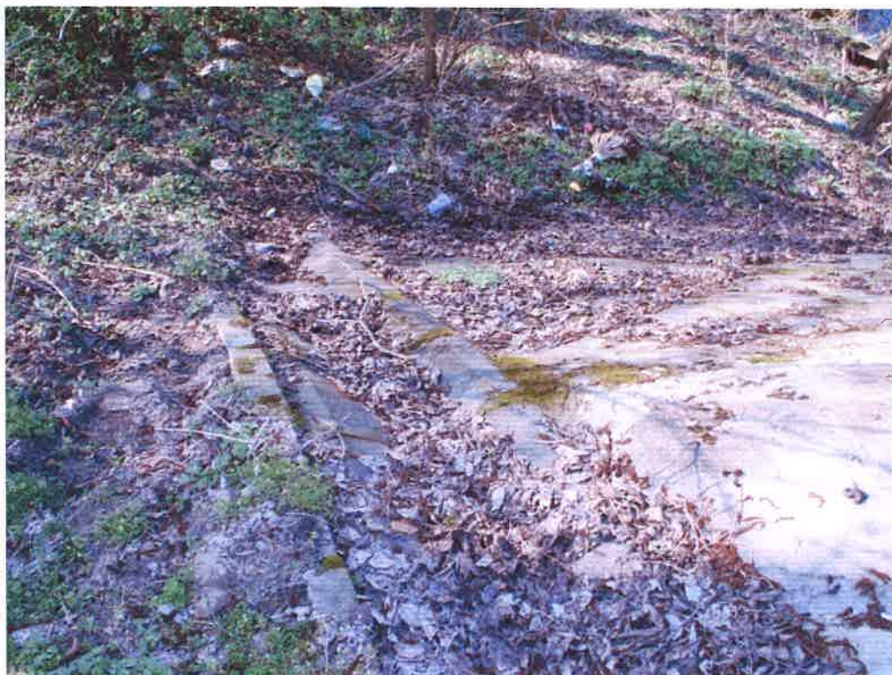
Fot. 9. Zanieczyszczony i niedrożny w dolnym odcinku ściek skarpowy.
