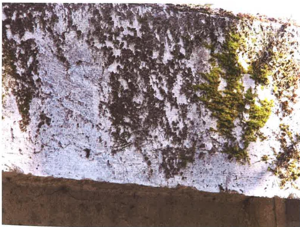
Fot. 12. Liczne porosty na belce podporęczowej.
