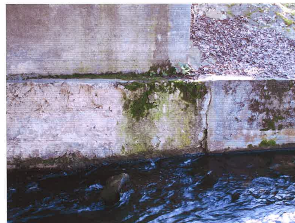
Fot. 16. Korozyja betonu przyczółka i ścianki kierującej.
