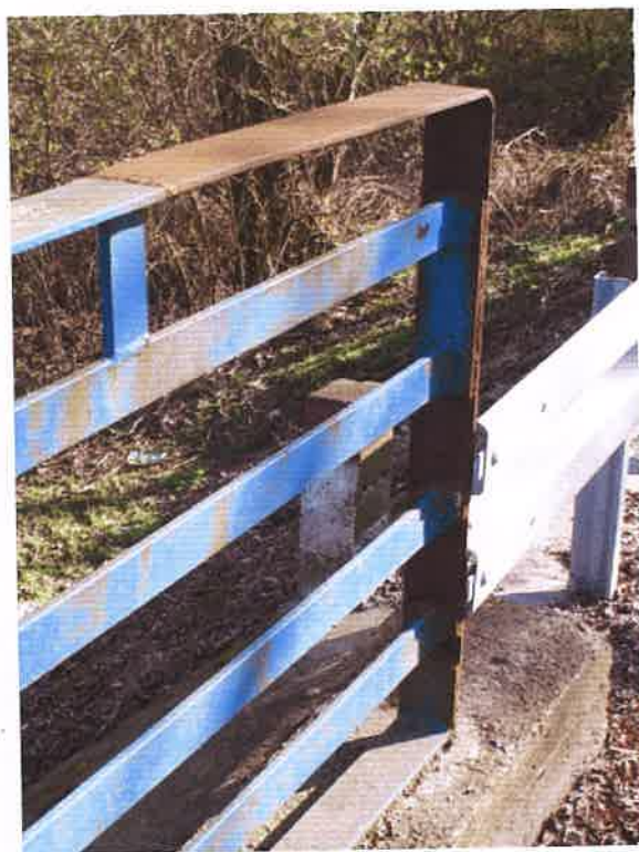
Fot. 7. Korozja balustrady.
