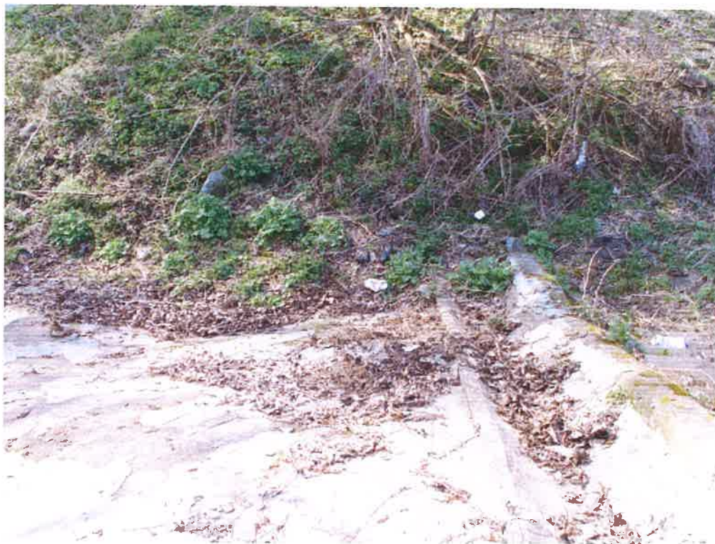
Fot. 11. Niedrożny w dolnym odcinku ściek skarpowy.
