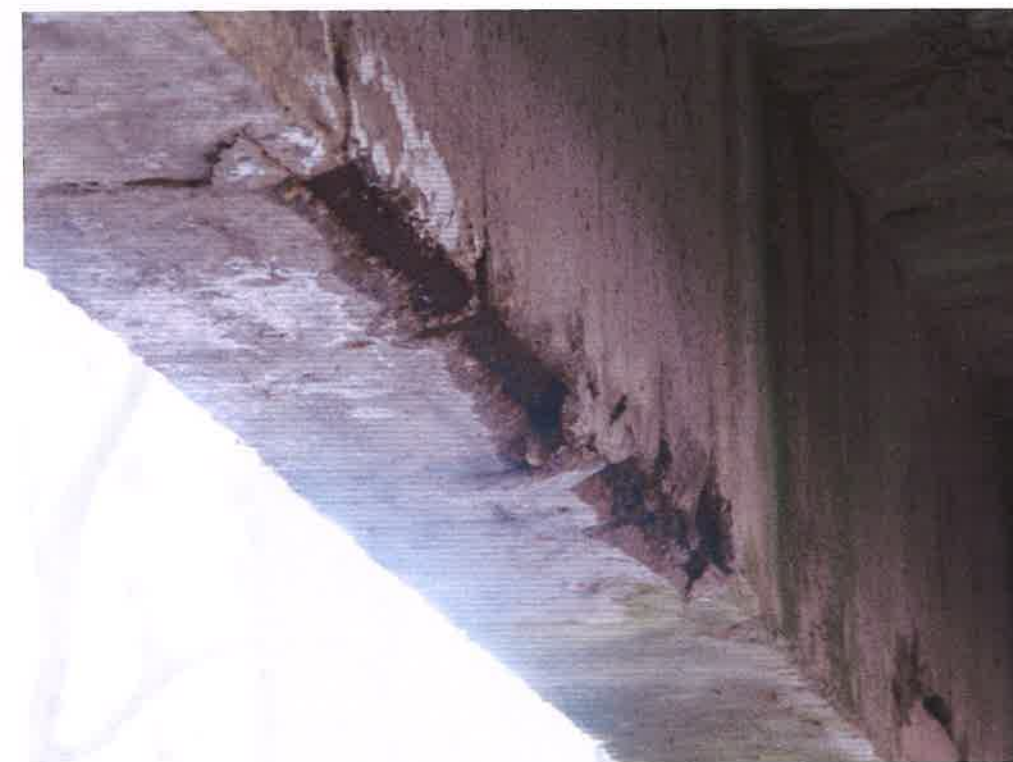
Fot. 13 Ubytek otuliny i zaawansowana korozja zbrojenia belki.
