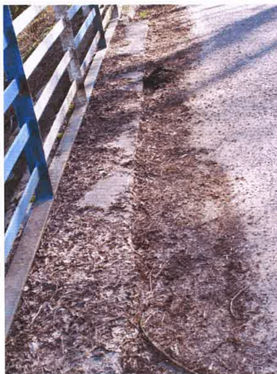
Fot. 6. Zanieczyszczenia jezdni i opaski.
