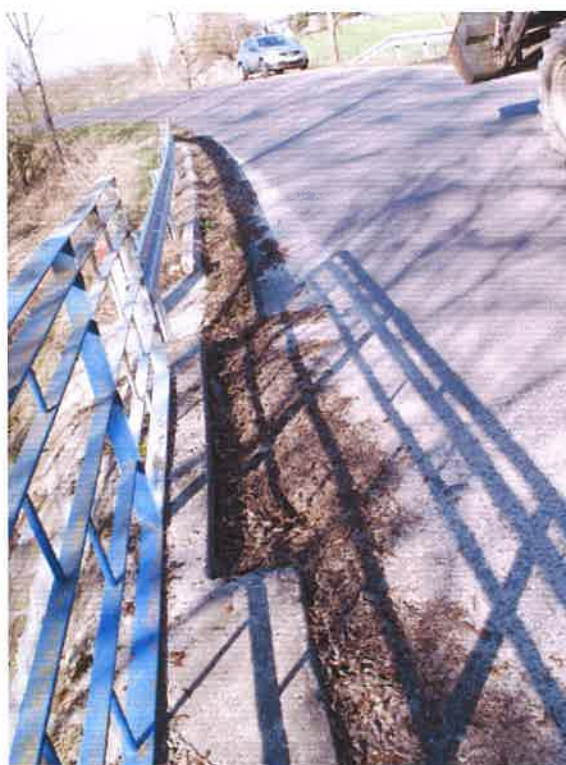
Fot. 10. Zanieczyszczony i niedrożny ściek podłużny.
