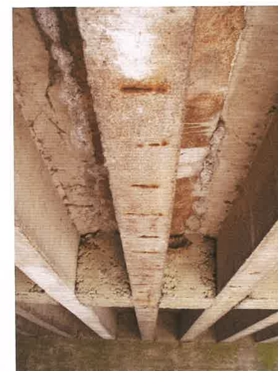
Fot. 14. Lokalne ubytki otuliny i korozja strzemion. Widoczne ślady przecieków.
