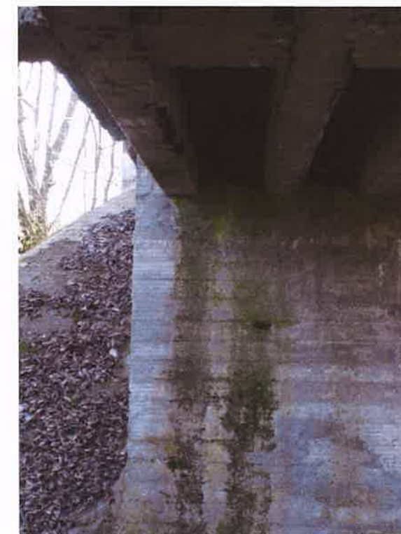
Fot. 15. Ślady po przeciekach na przyczółku.
