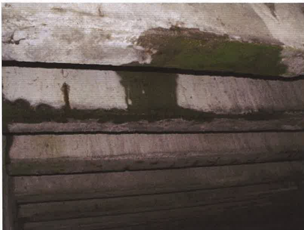
Fot. 5. Przeciek na prawym brzegu od dolnej wody.
