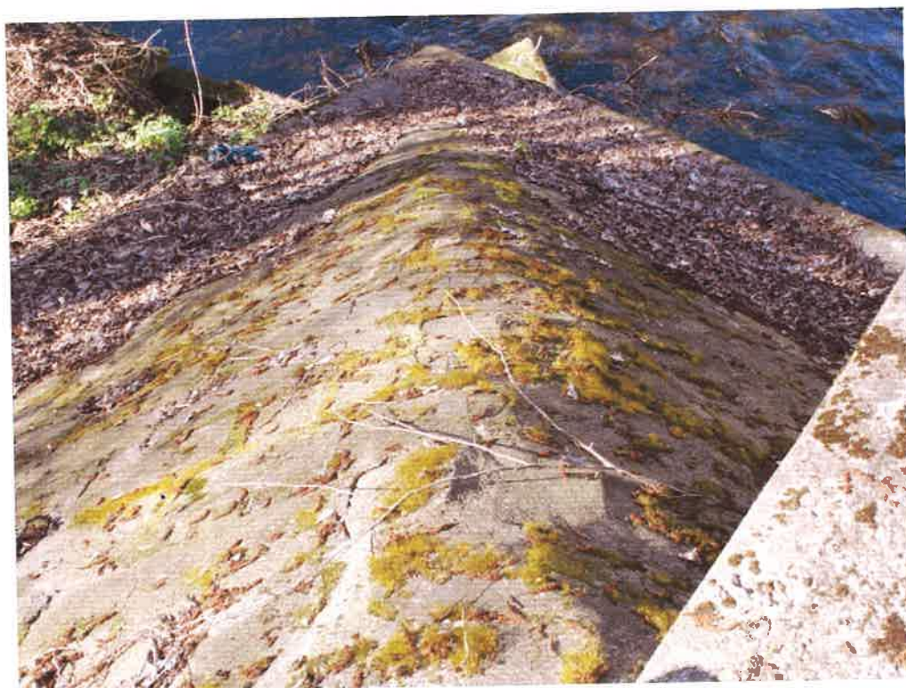
Fot. 8. Porosty na betonowym umocnieniu stożka.
